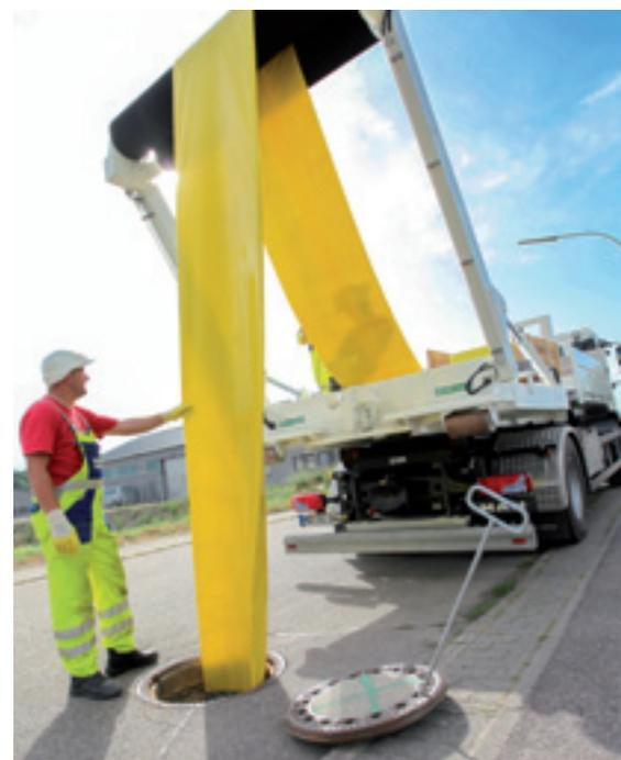
Sanierung einer Abwasserleitung im Schlauchlining-Verfahren
